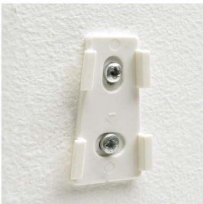
Fäst väggmonteringen med två medföljande skruvar.
